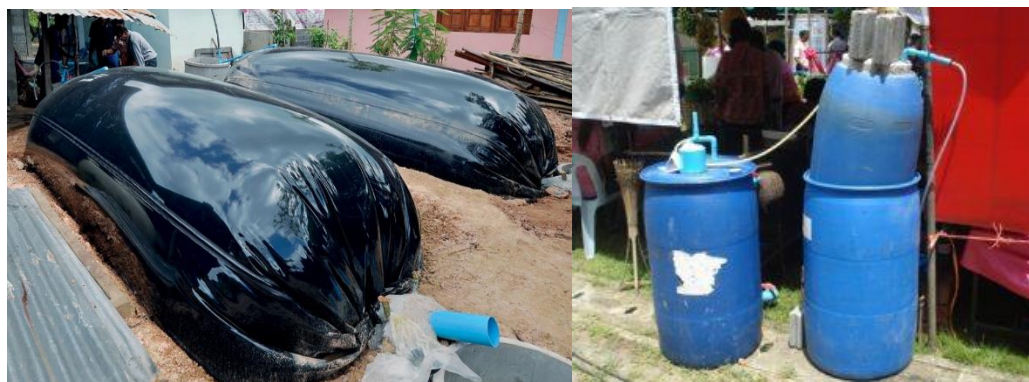
ภาพที่ 4-21 รูปแบบบ่อก๊าซชีวภาพที่ชาวบ้านมีความต้องการทำ (รูปแบบถังพลาสติก PVC ใช้พื้นที่มาก) และ ถังพลาสติก (ใช้พื้นที่น้อย) ที่มา : www.google.co.th .
