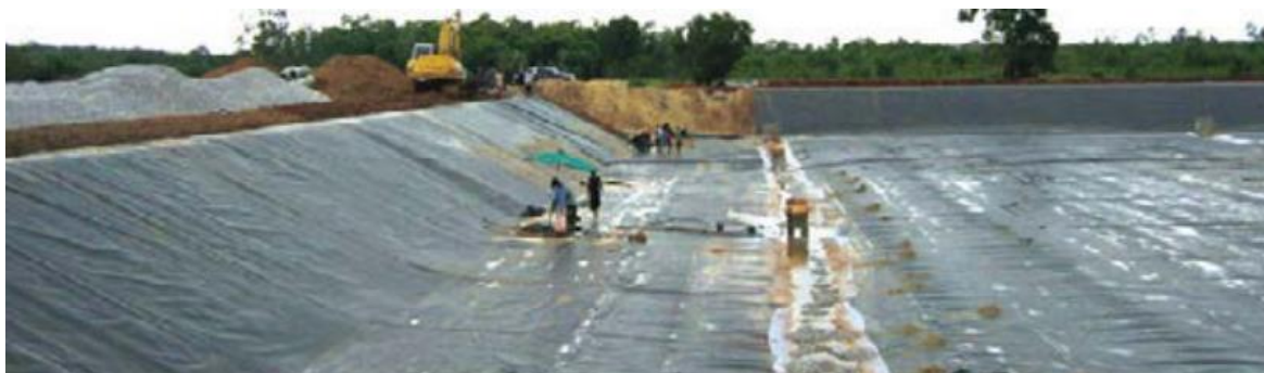
ภาพ 7 แสดงการฝังกลบแบบถูกสุขาภิบาลนั้น (Sanitary Landfill)
