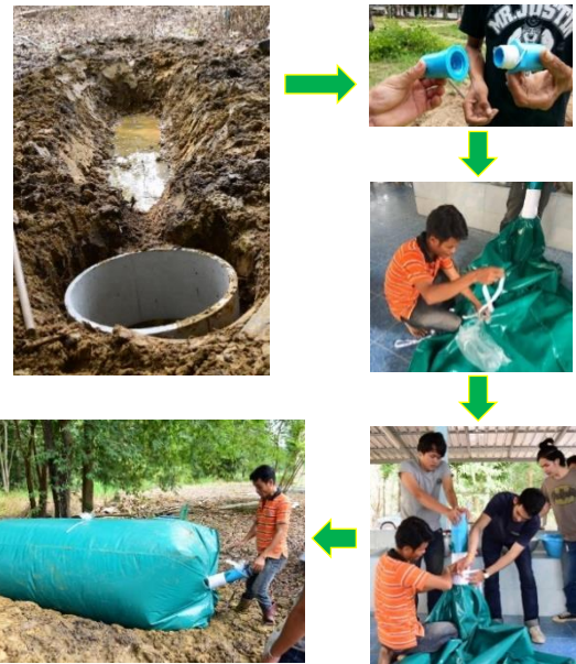
ภาพที่ 6 ขั้นตอนการประกอบชุดอุปกรณ์การสร้างบ่อก๊าซชีวภาพ
