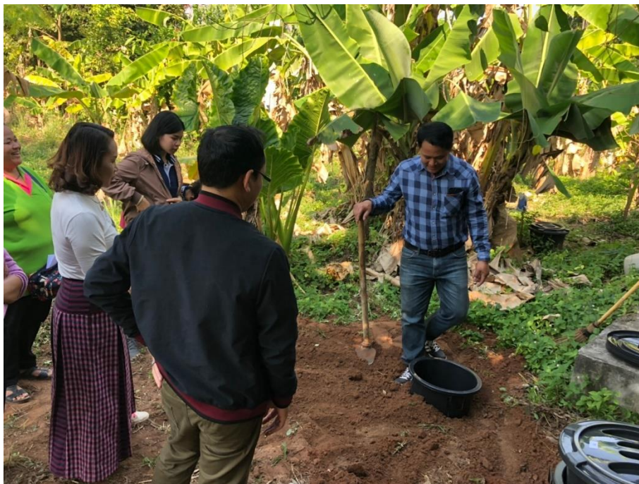
ภาพที่. 5 ขุดหลุมและนำถังลงหลุม
