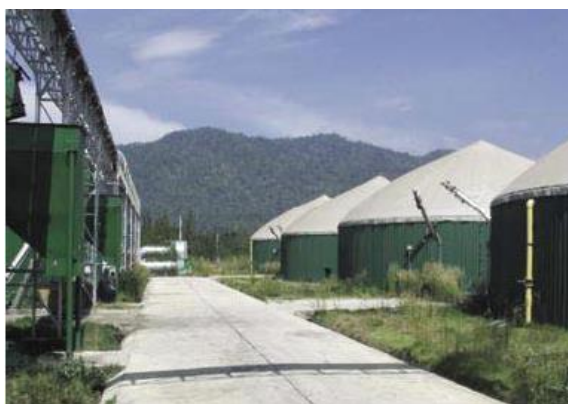
ภาพที่ 2-12 : ถังหมักขยะผลิตก๊าซชีวภาพเทศบาลศูนย์กำจัดมูลฝอยรวม จ.ชลบุรี ที่มา : www.oknation.net
