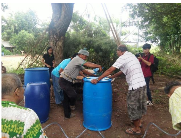
ภาพที่ 3-5 การเจาะรูถังโดยใช้เครื่องไฟฟ้า อาทิ สว่าน เลื่อยไฟฟ้า
